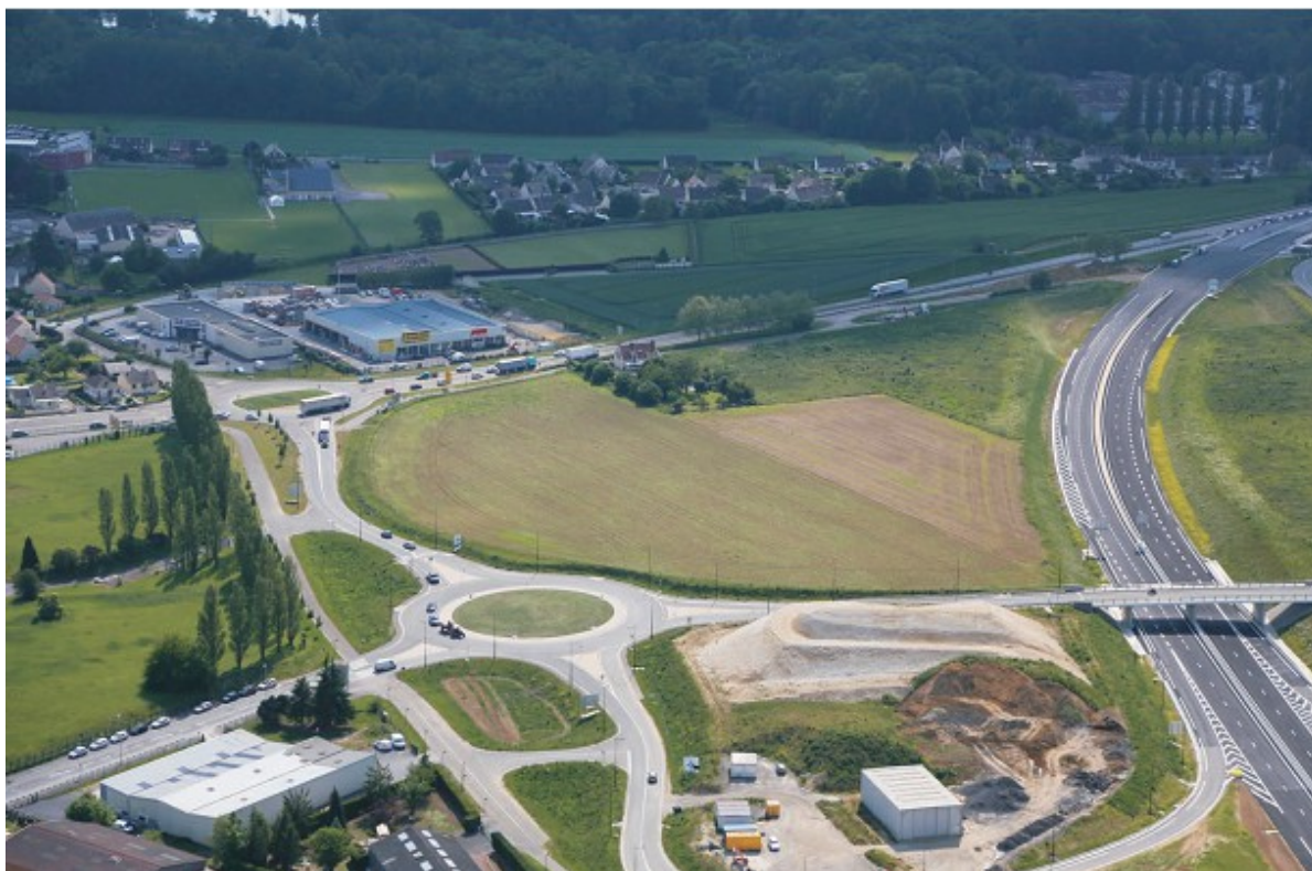
RN 31, déviation de Breuil-le-Sec, Nointel et Catenoy (source DREAL Picardie)
